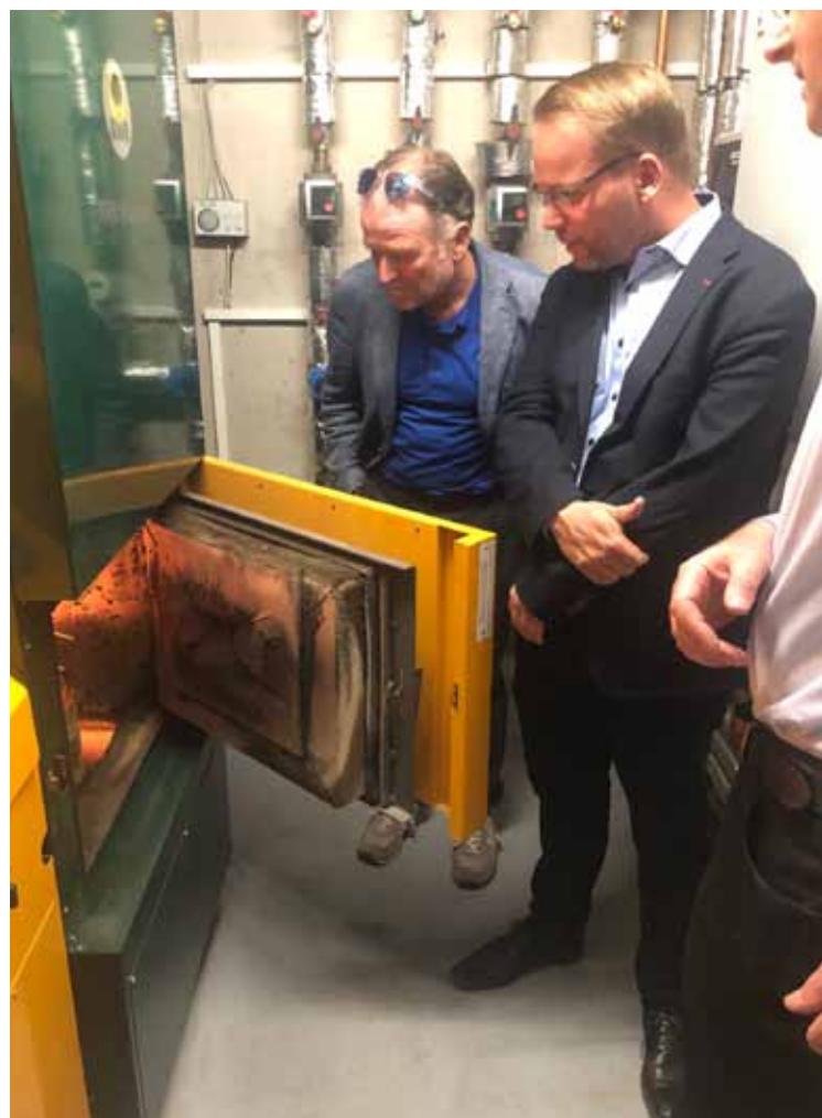
Gemeinsam mit Dr. Martina Sabel (Bundesverband Wärmepumpe) und Martin Benetele (Deutscher Energieholz- und Pelletverband) bei der Besichtigung einer Pellet-Heizung.
